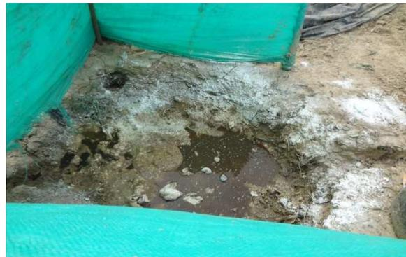
Se evidencian en la celda transitoria unos puntos denominados sumideros de lixiviados, los cuales presentan no se encierran debidamente y generan condiciones de malos olores y afectación a la salud de los operarios. Lo anterior debido a un inadecuado manejo de los lixiviados y aguas lluvias dentro del área de la celda transitoria lo cual produce una cantidad que desborda la capacidad de la infraestructura existente.
