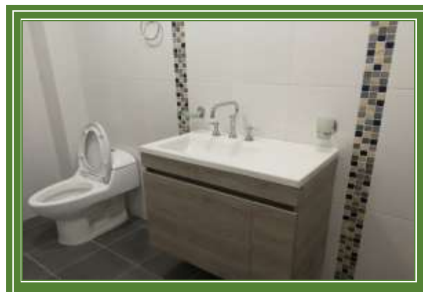
Condiciones actuales baños
