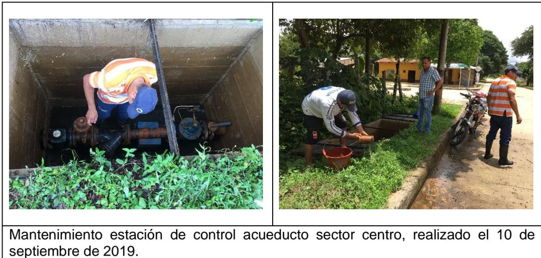
Una vez realizado el respectivo mantenimiento de la estación de control, que consistió en el lavado de filtro, se realizó la apertura del hidrante de la zona, con el objetivo de evitar impurezas en el agua distribuida a la población de este sector.
