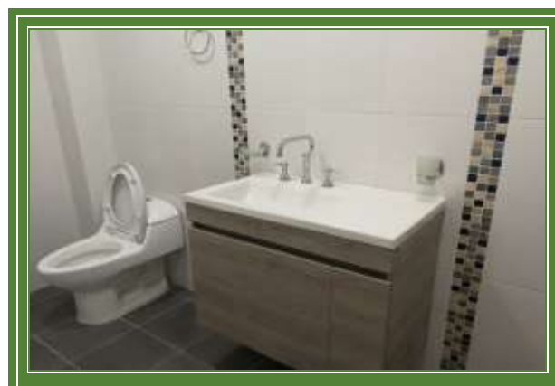
Condiciones actuales baños
