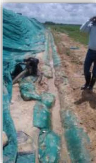
Como se evidencia en la imagen inmediatamente anterior, la sección del canal se considera inadecuada para evacuar el área aferente de lluvias del relleno sanitario, la cual en algunas ocasiones por la acción fuerte de las lluvias podría desbordarla y generar una contaminación del suelo por causa de los lixiviados.
